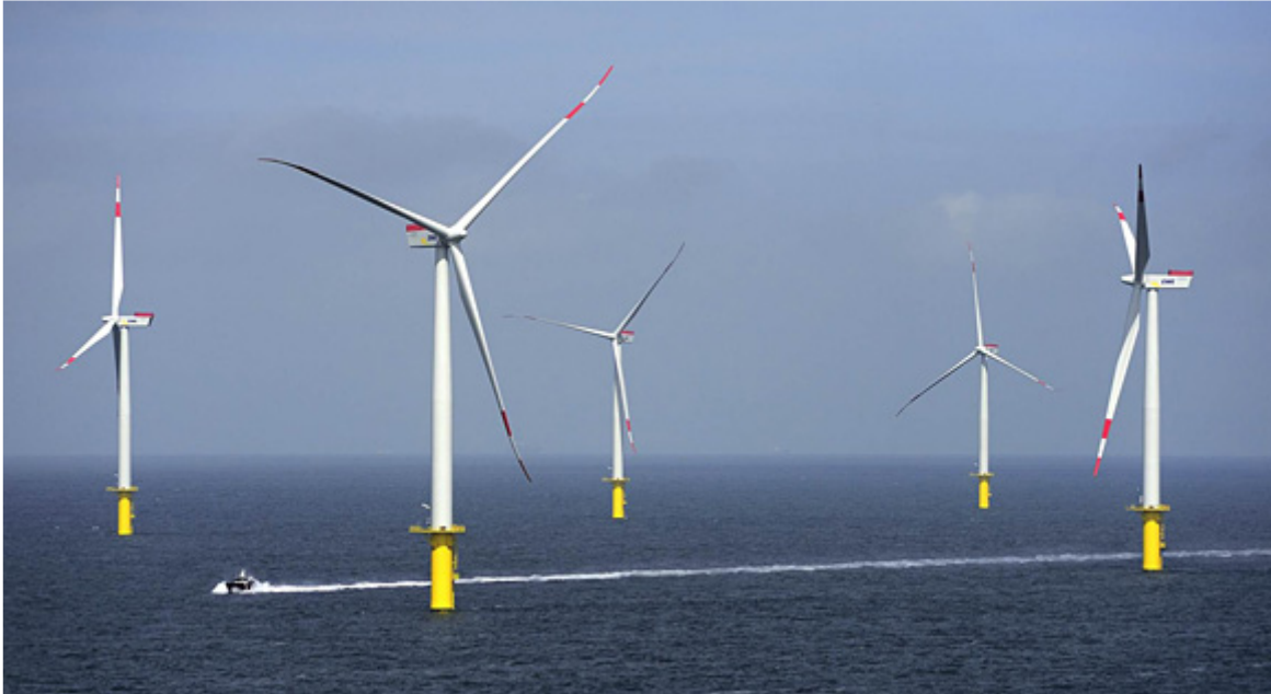
Der neue Windpark Riffgat in der Nordsee © EWE AG/ Ibeler
